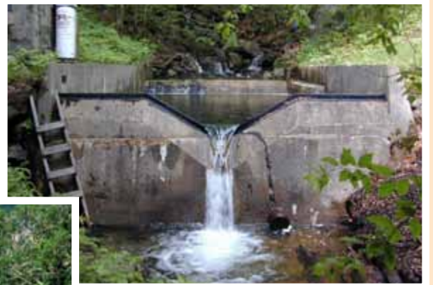
Figura 27. Presa para medir el caudal. Copyright Hubbard Brook Experimental Forest. Fuente: USDA, www.hubbardbrook.org
