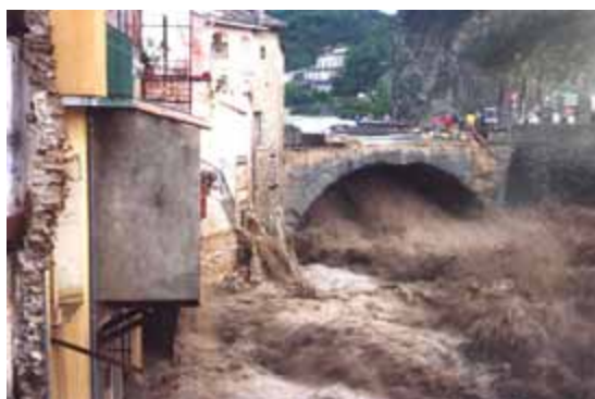
Figura 29. Crecida repentina en Vaison-la-Romaine el 22 de septiembre de 1992. Este puente romano, construido en el siglo I d.C. sobre el río Ouvèze resistió la inundación mientras que otros puentes y edificios más modernos no la resistieron. Foto: M.J. Tricart.
