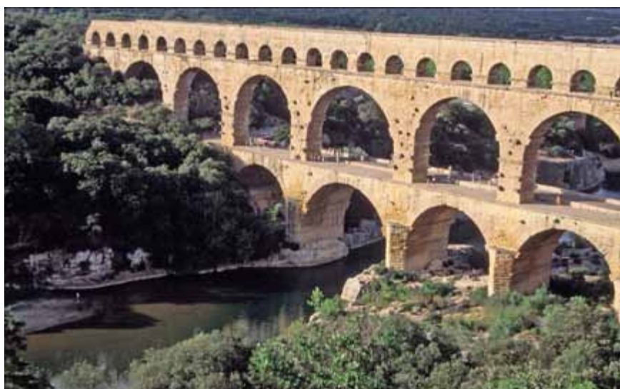
Figura 39. El famoso acueducto de Gard (2000 años de antigüedad) en el río Gardon. Construido por los romanos para abastecer de agua azul a la ciudad de Nimes (Francia). Foto: C. Birot.
