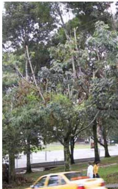
15.13 Poda para evitar interferencia con los cables eléctricos, realizada en forma inapropiada. Fraxinus udhei , Pereira, Colombia.
